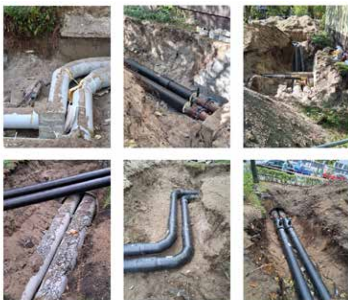
// Fot. Modernizacja sieci ciepłowniczej na terenie miasta.
